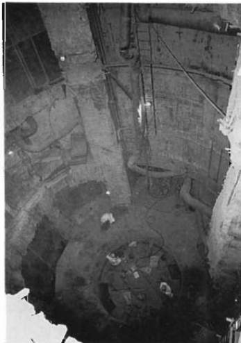
(写真1) 放射線遮蔽体撤去後の状況
